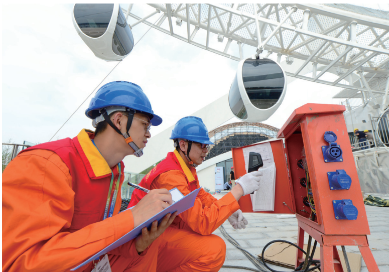
▲国网四川电力成都高新连心桥共产党员服务队队员进行测温检查作业
